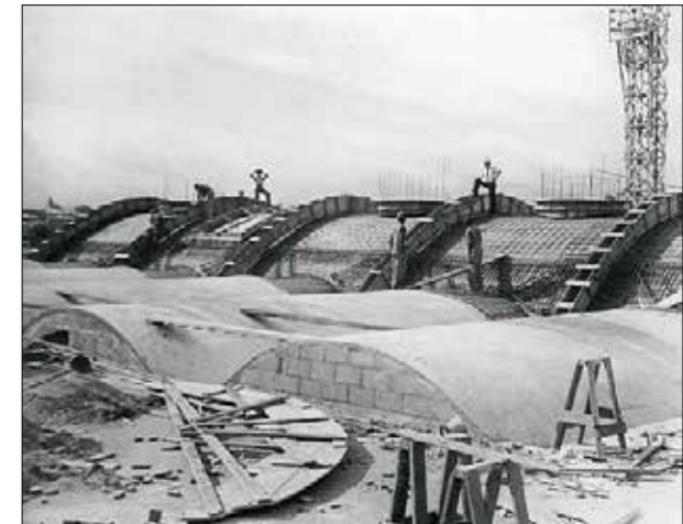
En primer plano, ya vertidas, las pequeñas bóvedas de los arcos. En el fondo, se prepara el vertido final sobre la bóveda central del Mercado.
