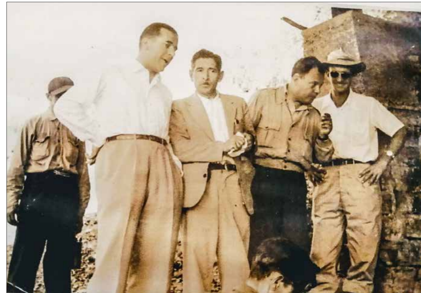
Manuel de Moya Alonso, Secretario de Estado de Industria y Comercio, Capataz señor Sánchez, Terenzio Seravalle, Renato Zoppis, Giuseppe Borrione y Luigi Reboa, técnico en soldeos, frente al Galería n. 6. Foto tomada en el 1952.
