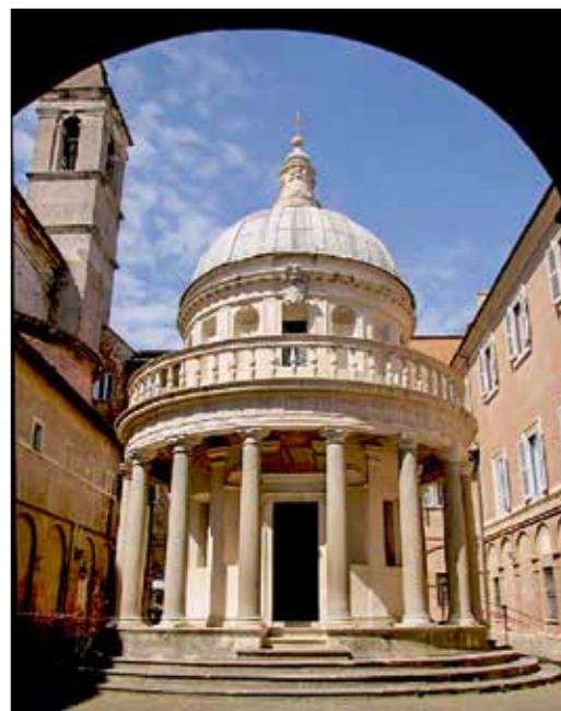
El Templete o Tempietto de San Pietro en Montorio a Roma, obra de Bramante (1502): izquierda, foto frontal; centro, planta baja; derecha, sección.
