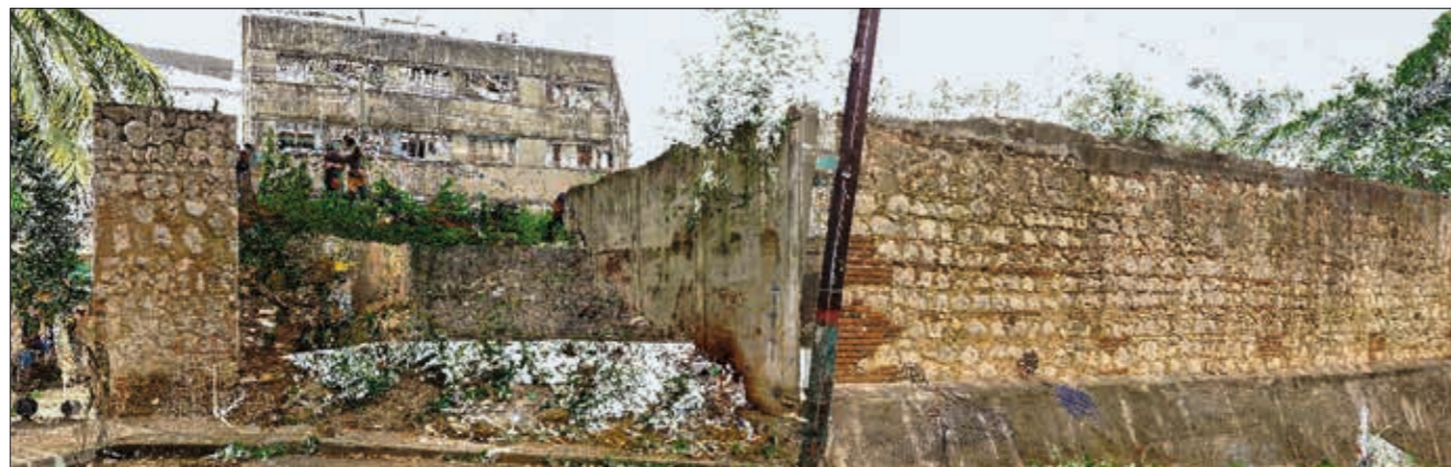
Vista della nuvola di punti del Bastione collocato in prossimità dell'Ermita de San Antón. Il sito, non essendo riconosciuto come monumento dalla popolazione, versa in condizioni critiche: nella parte superiore è coperto da una vegetazione incolta e sono ben visibili tracce di un edificio che vi era stato costruito utilizzando il Bastione come basamento e poi crollato su se stesso.
