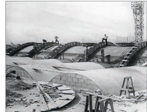
In primo piano, già gettate, le piccole volte degli archi. Sullo sfondo si prepara la gettata finale sulla volta centrale del Mercato.
