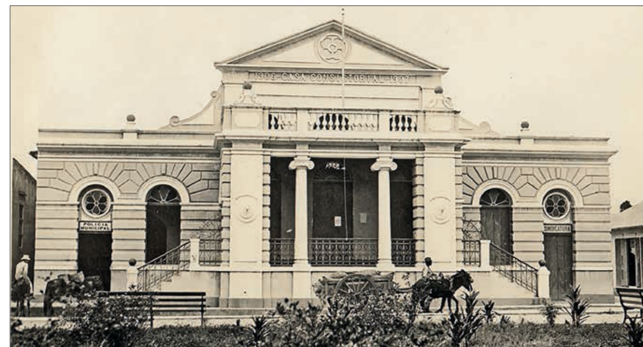
Il Municipio di Moca, costruito dall'ingegner Alfredo Scaroina Montuori.
